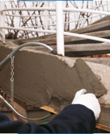
Aplicación de Mapegrout 430 con llana
