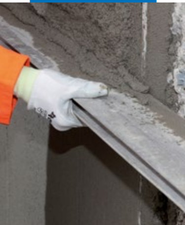
Nivelación de Mapegrout 430 con perfil de aluminio de nivelación
