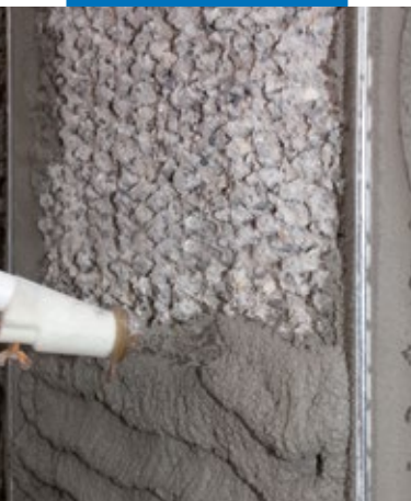
Aplicación de Mapegrout 430 lanzado
