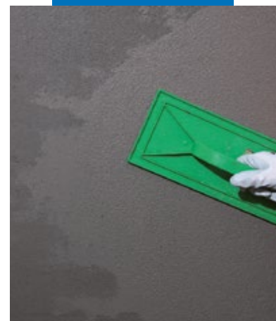
Allanado de Mapegrout 430
