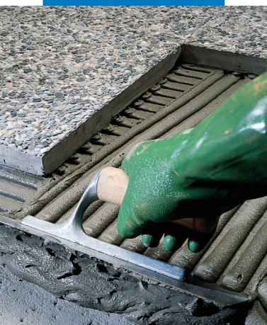
Colocación de las baldosas con grabado en relieve en el exterior
