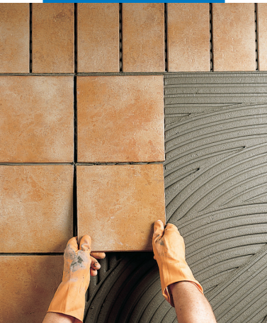
Colocación de clinker en exterior
