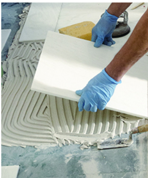
Aplicación del adhesivo
